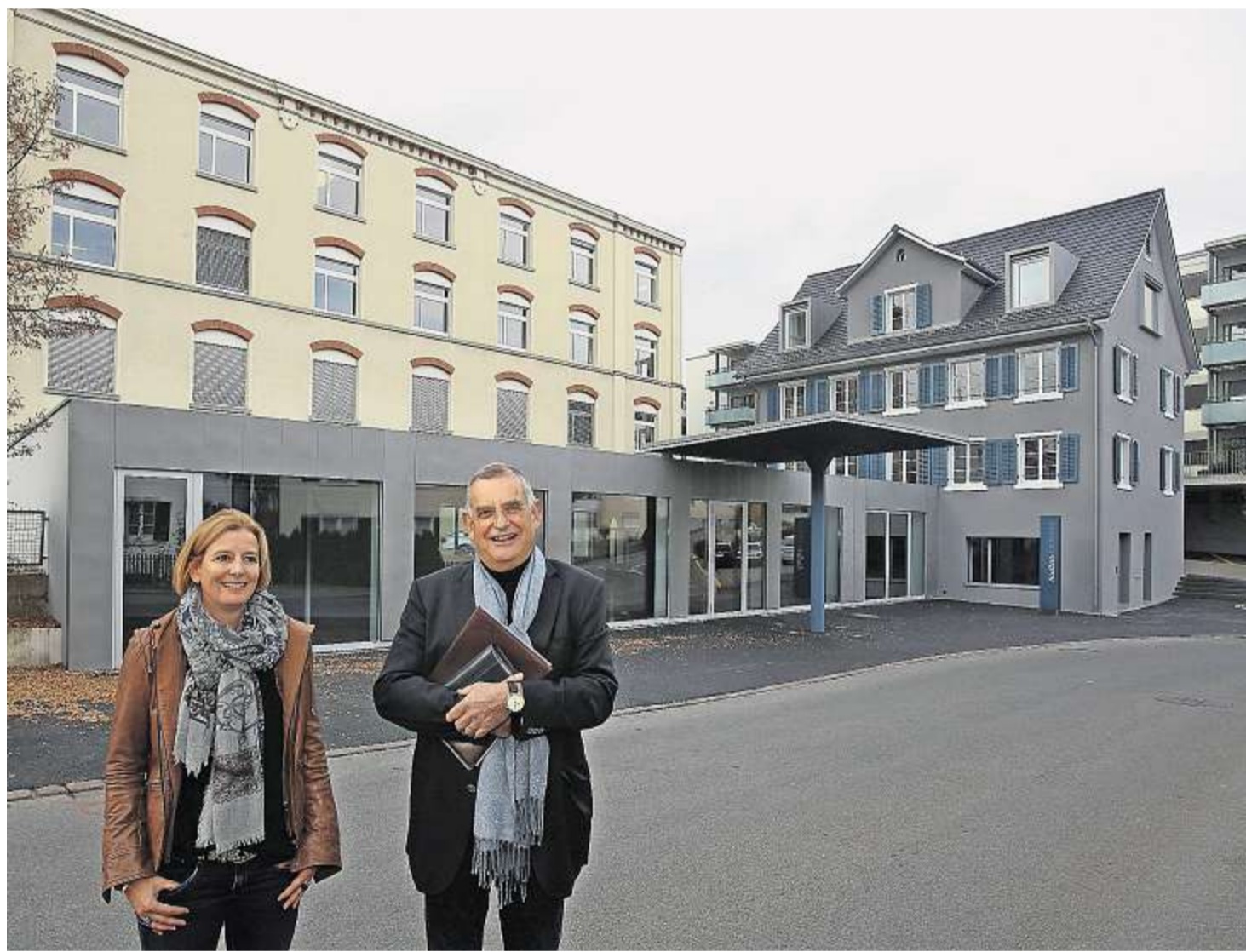
Mit Hilfe von Architektin Corinne Müller (links) wurde die ehemalige Delta-Garage an der Florhofstrasse 15 in eine neue Heimat für Kultur verwandelt. Der Präsident des Vereins Kulturgarage, Fredy Fischli, begrüsst am Samstag die Öffentlichkeit in den neuen Räumen. Sabine Rock
